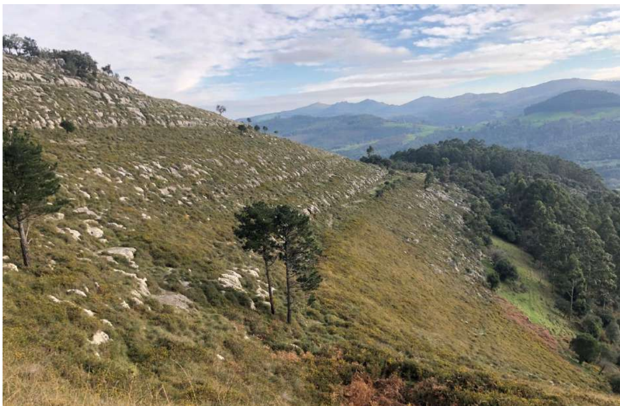
Fig.8. Ladera por donde se traza el vial de acceso al PE entre Pk 1+900 y 2+100
